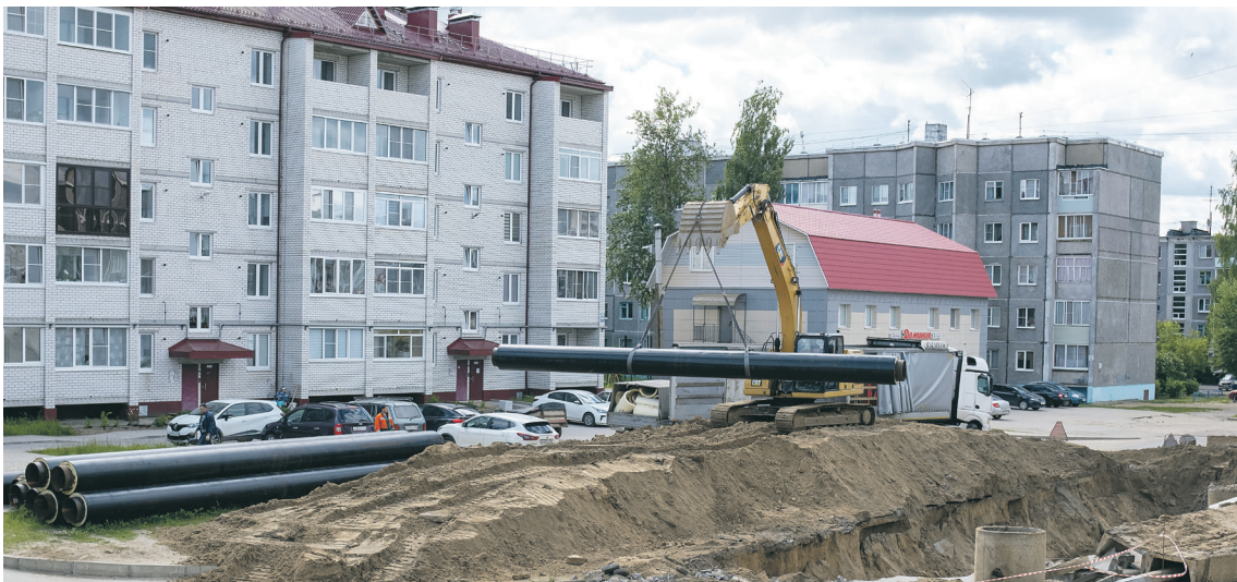
Замена участка теплосети у ТЦ «Пальмира»
